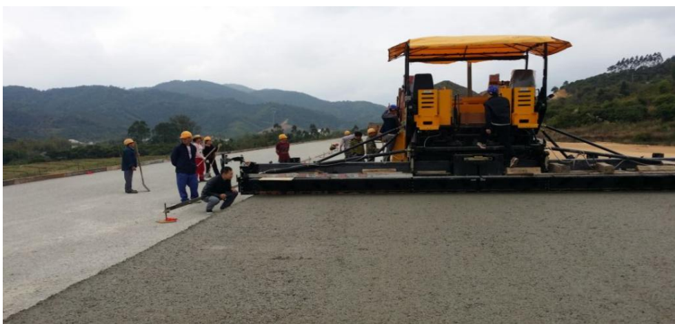
图 5-18 我校教授为企业提供水泥碎石基层和沥青拌和施工技术指导
